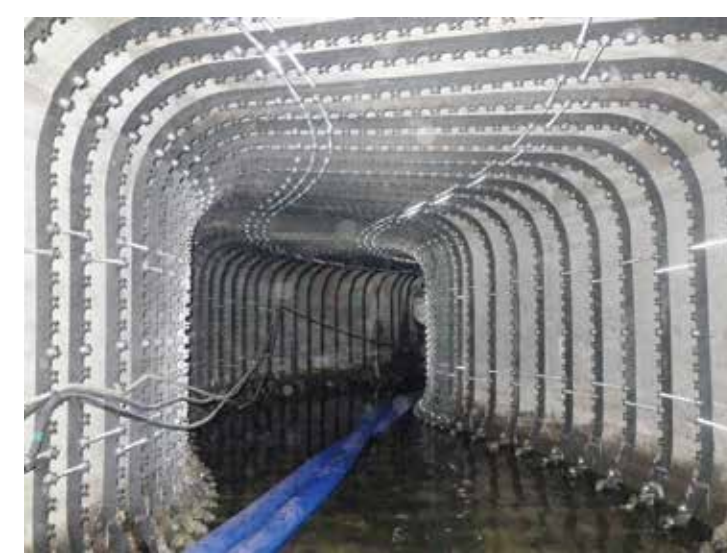
S字屈曲部の鋼製リング施工状況
