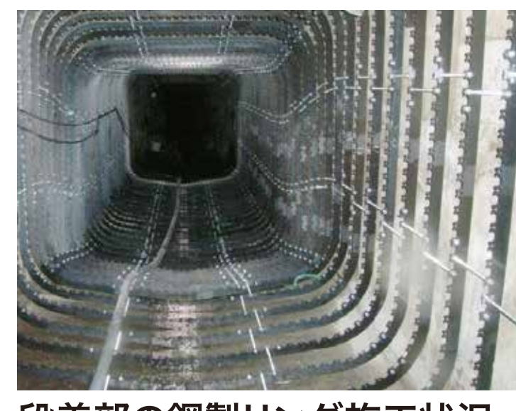
段差部の鋼製リング施工状況
