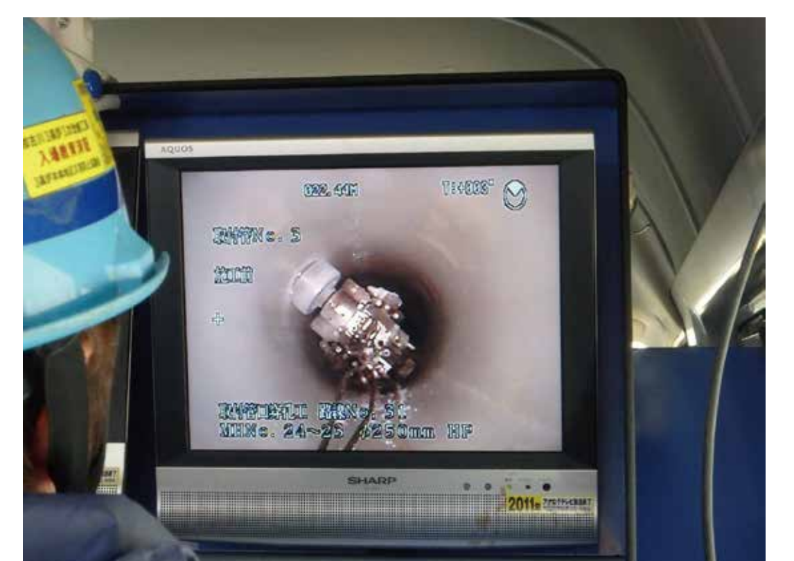
管きょ内から取付管口を穿孔中
